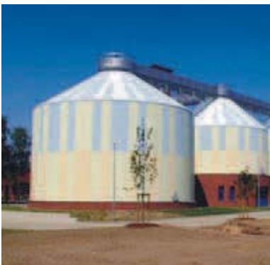
Faultürme der Kläranlage Braunschweig
