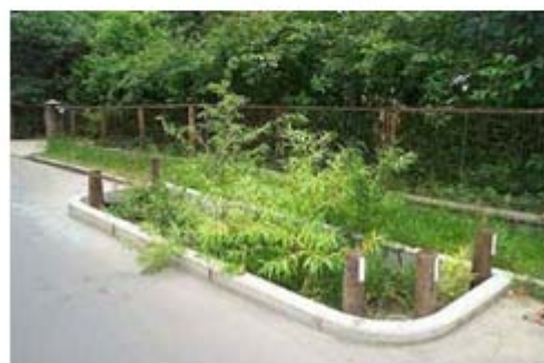
Mulden-Rigolen-Tiefbeet in Birkenstein, Brandenburg (Foto: Sieker)
