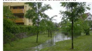
Notentwässerungsmulden, Stuttgart (Quelle: Ramboll Studio Dreiseitl, 2018)
