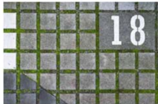
Wasserdurchlässige Pflastersteine, Ernst-Reuter Haus (Quelle: Andreas Süß, 2018)
