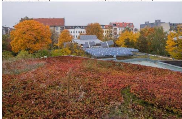
Dachbegrünung mit Photovoltaik, UFA Fabrik (Quelle: Andreas Süß, 2018)
