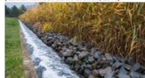
Retentionsbodenfilter, Adlershof (Quelle: Andreas Süß, 2018)
