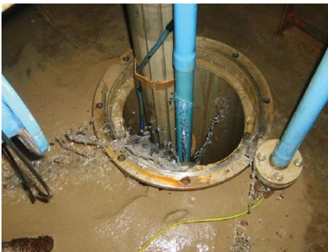
Bild 4: Links: Brunnen mit Fremdwasserzutritt über undichte Brunnenkopfdichtung im Frühjahr 2011; Rechts: Hauff-Dichtung (mechanisch) als neuer Standard-Dichtungstyp bei den BWB [Wittstock 2012]
