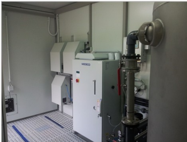
Abbildung 5.4: Drei Sauerstoffkonzentratoren und Ozongenerator
