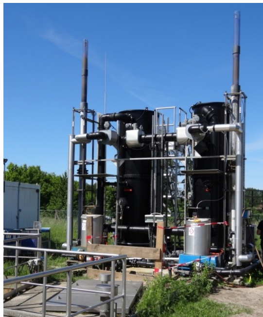
Abbildung 4.1: Pilotflockungsfilter zur Untersuchung der weitergehenden Abwasserreinigung auf dem Klärwerk Münchehofe
