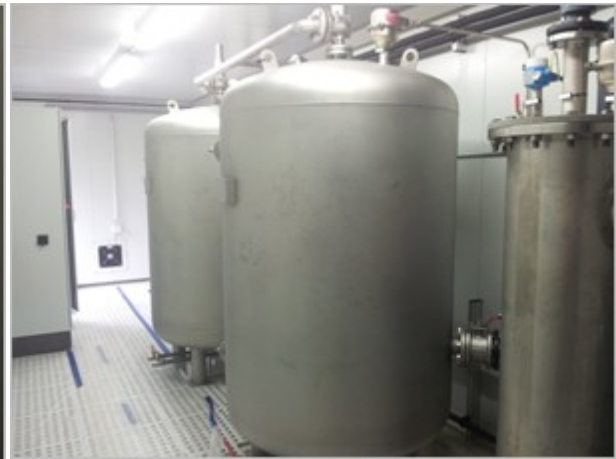
Abbildung 5.5: Zwei Reaktionsbehälter mit je 2 m 3 Volumen und nachgeschalteter Ausgleichstank
