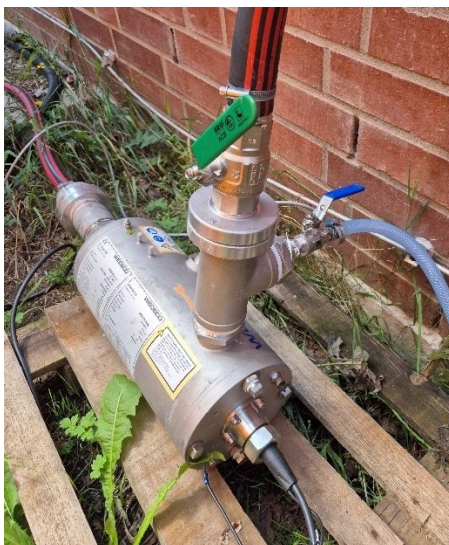
Abbildung 5: UV-Desinfektionsanlage Spektron 2e.
