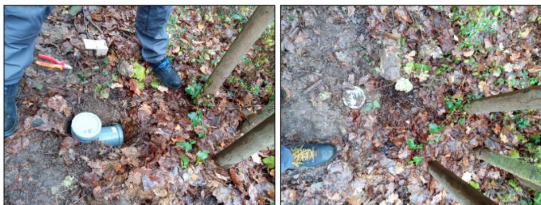
Abbildung 27: Impressionen vom Einbau eines Bodenfeuchtemessgeräts
