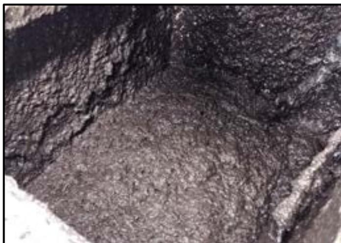
Bild 50: Schwimmschlamm im Nitrifikationsbecken
