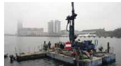
Erste Bohrungen und Bodenbeprobung in der Spree First drillings and soil sampling in the Spree
