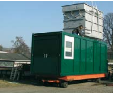
Aufbau der ENREM Demonstrationsanlage Containerplant in construction
