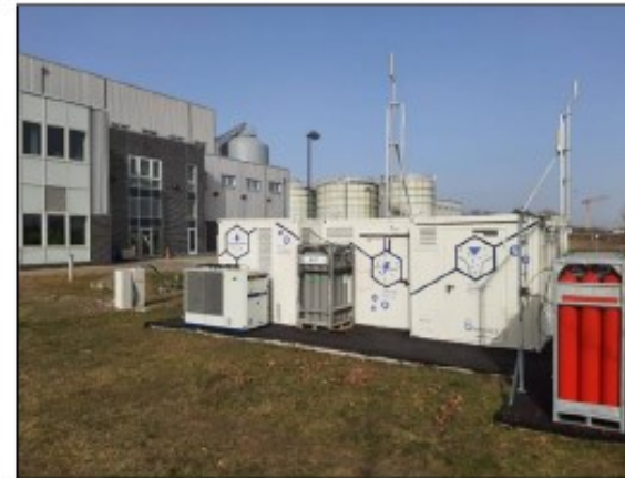
Berliner Wasserbetriebe - Waßmannsdorf -
